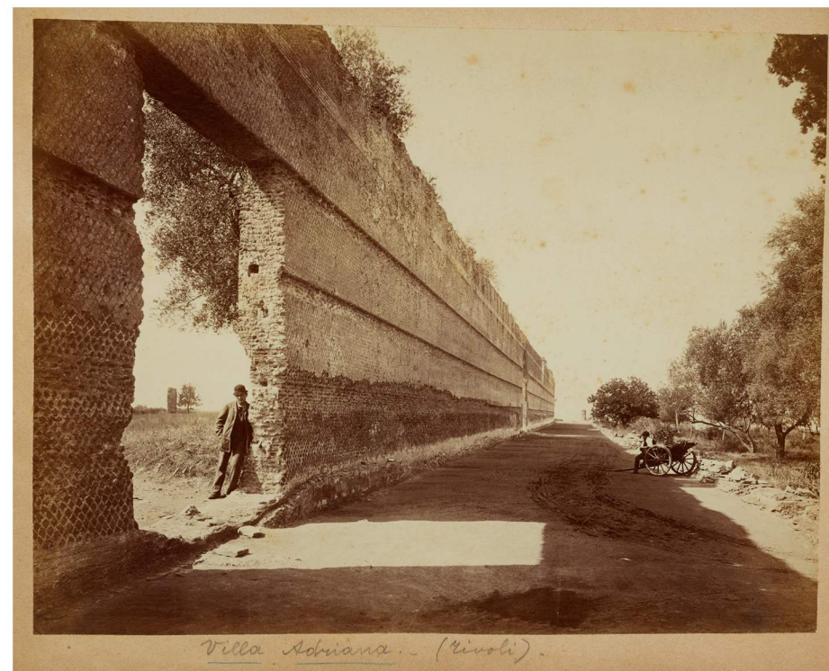
Veduta del muro del Pecile; oltre il varco, la spianata prima dei lavori sulla vasca. (ICCD Fondo Ministero della Pubblica Istruzione)
