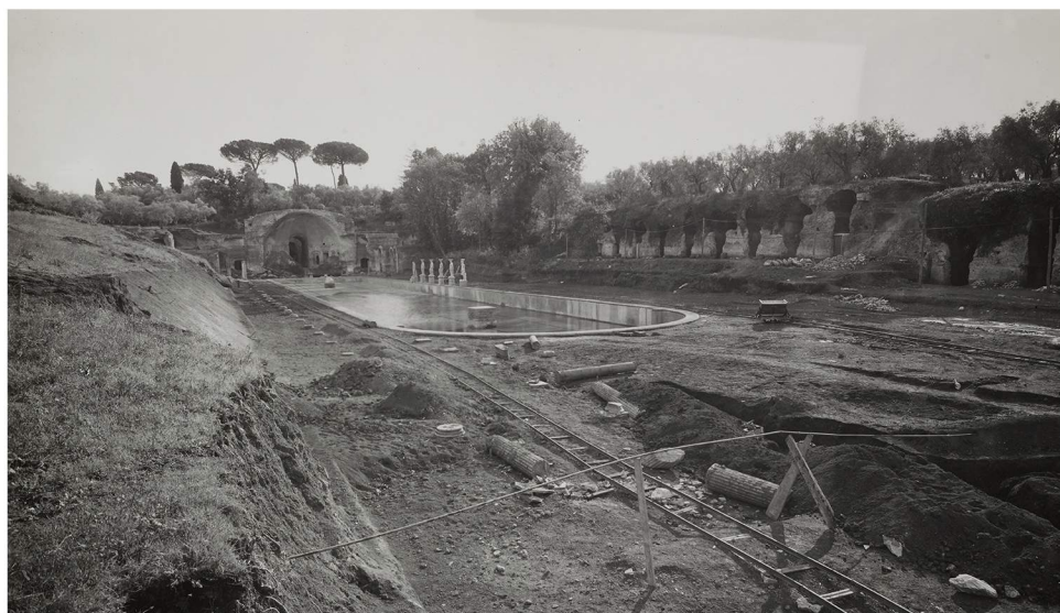
Il Canopo durante i lavori di scavo e restauro (ICCD, Fondo Archivio Ministero della Pubblica Istruzione, data ripresa 1956)
