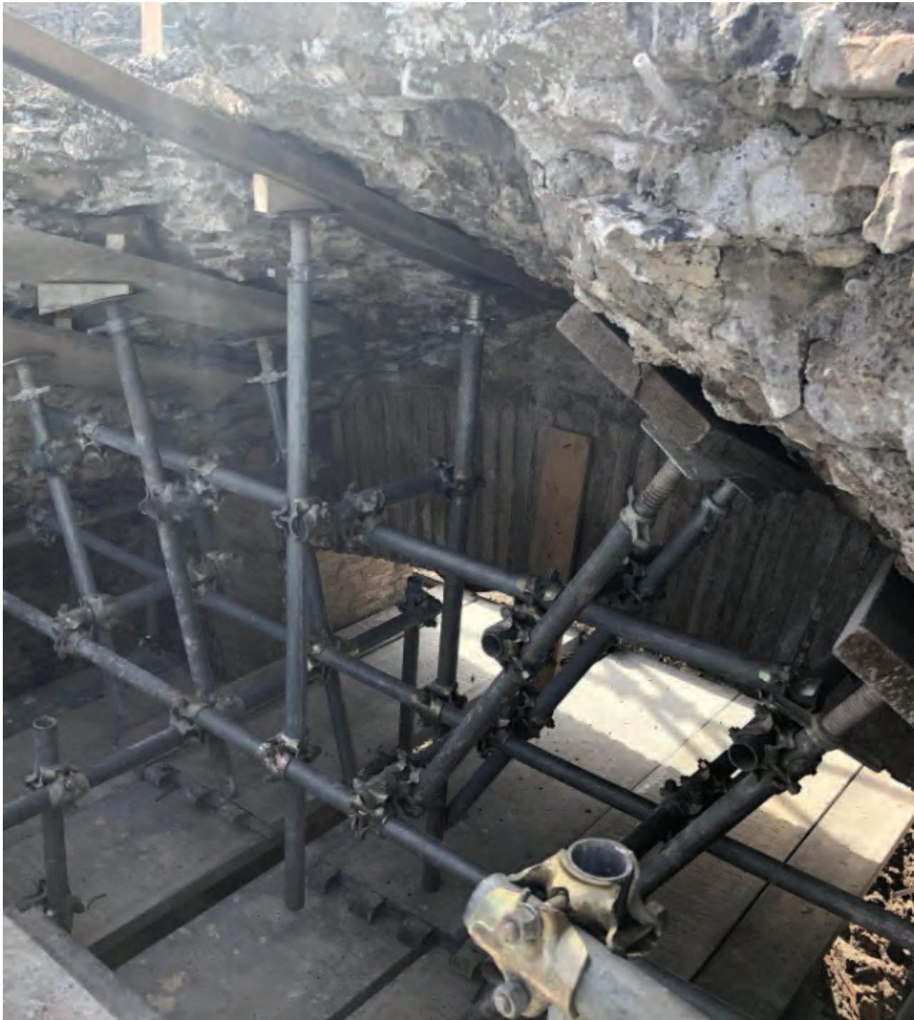
Sala Ottagona - interno Puntellamento delle porzioni conservate della volta preliminare alla rimozione dell'impermeabilizzazione dell'estradosso.
