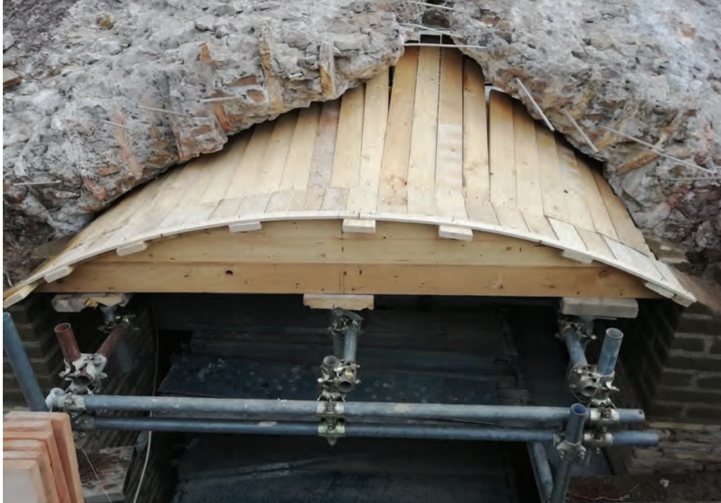
Sala Ottagona - esterno Realizzazione di una centinatura lignea per la ricostruzione degli archi secondo la geometria originaria di progetto.
