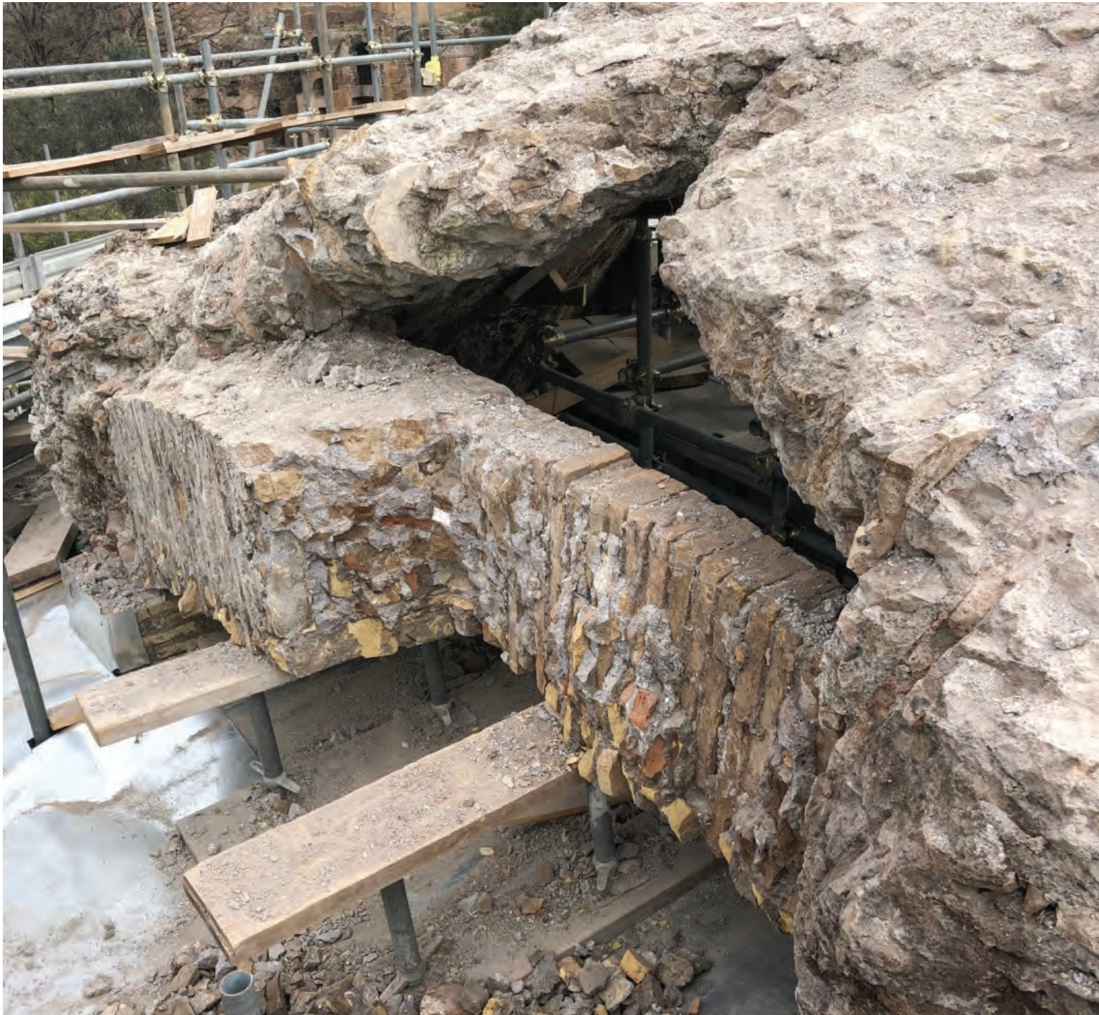
Sala Ottagona - esterno Rimozione controllata degli archi di restauro per non creare eccessive sollecitazioni alla struttura.
