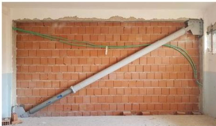
>> Figura 10 Controvento dissipativo posato in opera presso la Scuola Elementare Castellone
